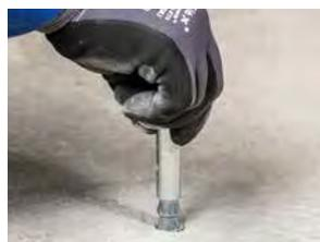
**Oben:** Gewindehülse wird in Punktfundament gesetzt.
